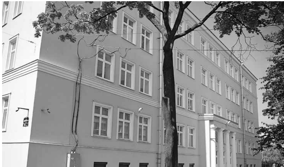
Здание гимназии № 70 после капитального ремонта.
